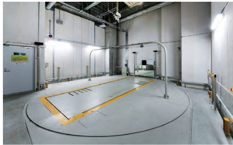
ターンテーブル内蔵(テーブル旋回方式)リフト
