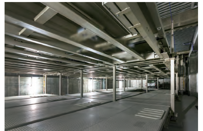
駐車場格納部
