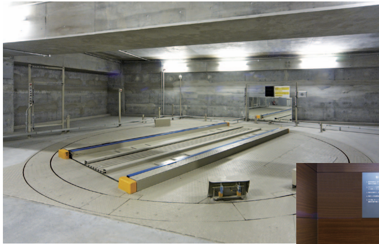
ターンテーブル内蔵型のCSパーキング(B号機)
