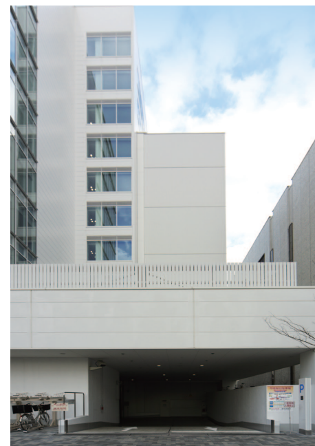
建物に隣接した限られたスペースを活かして設置されたE.L.パーキング
