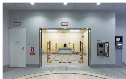
ハイルーフ車の収容高さ確保した乗り込み口
