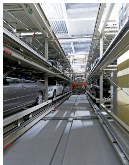
平面往復方式CSパーキングの構造写真
