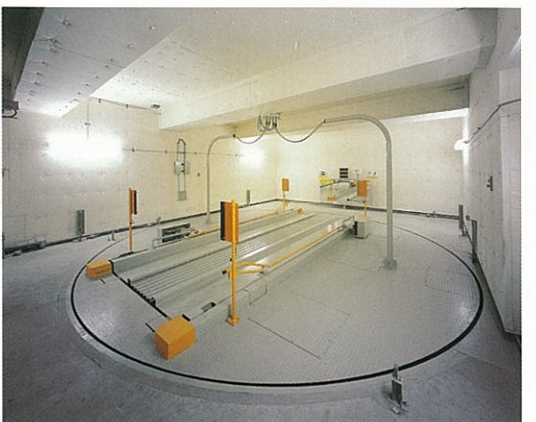
庫内は防音仕様で、ターンテーブルが内蔵されている
