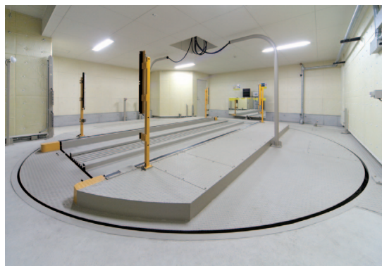
Bブロックは前進入出庫ができるターンテーブル内蔵型
