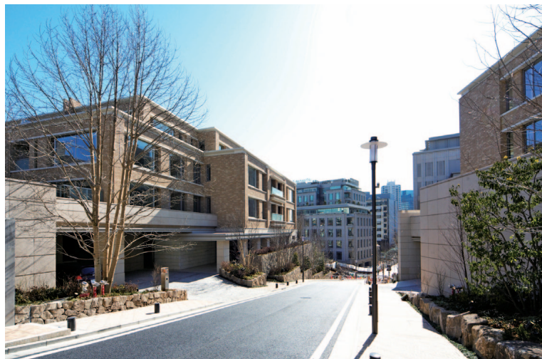
風光明媚の地として知られる御殿山エリアに誕生(左側:Bブロック,右側:Dブロック)
