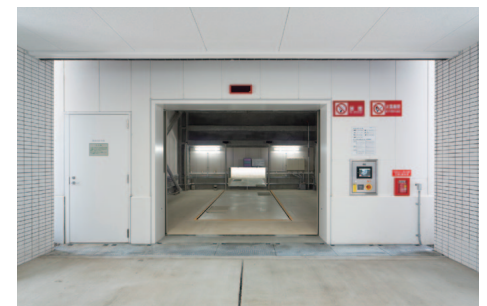
全車ハイルーフ対応の入出庫口スペース
