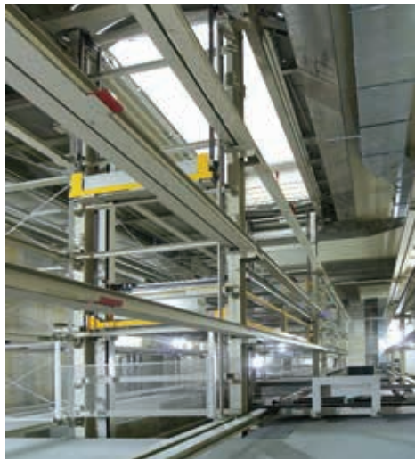
CSパーキング・サイドリフト乗込方式を採用した設計レイアウト
