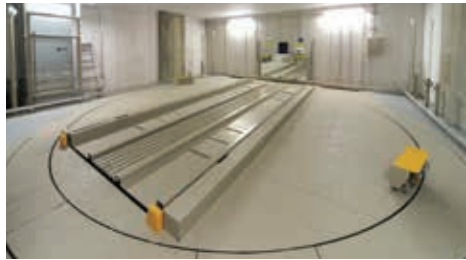
前進入出庫を可能にする、ターンテーブル内蔵型（CSパーキング）
