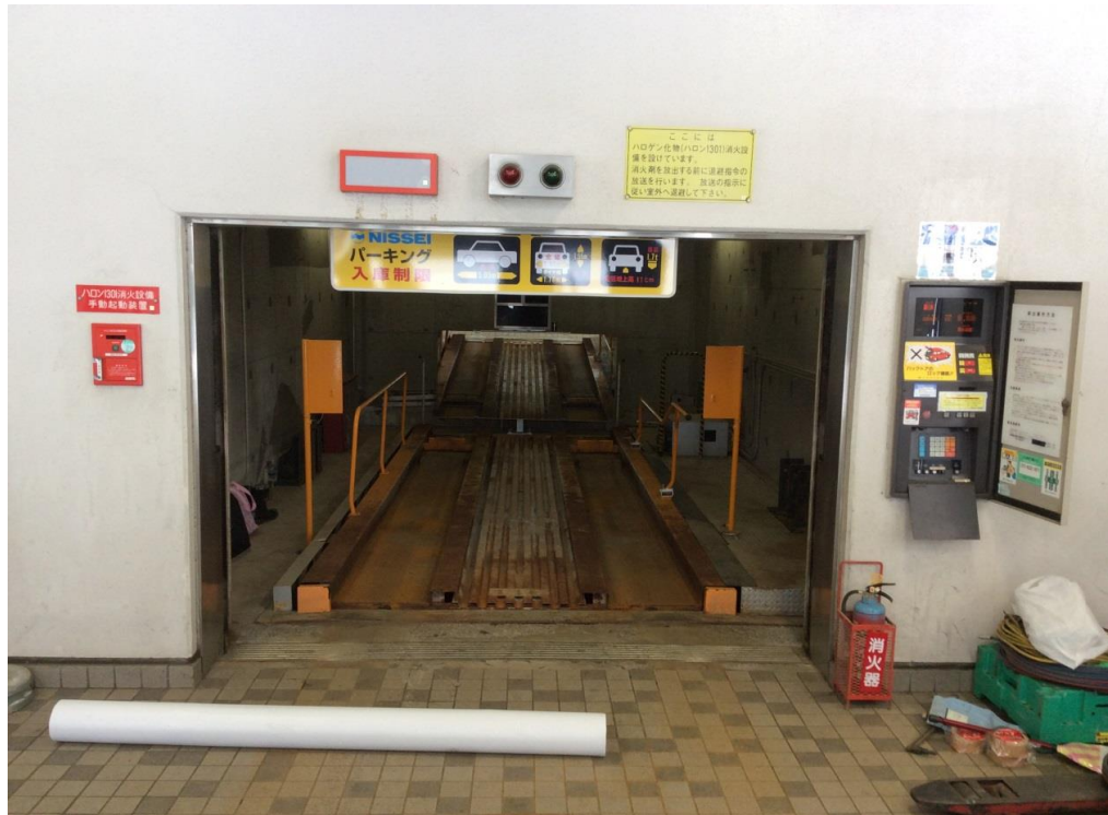
1.リプレース工事前
