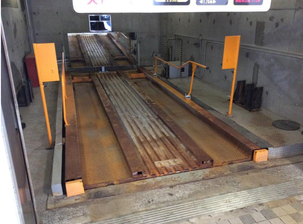
1.リプレース工事前(半ドア事故防止右側のみ可動フェンス付・雪害によりトレーが腐食)
