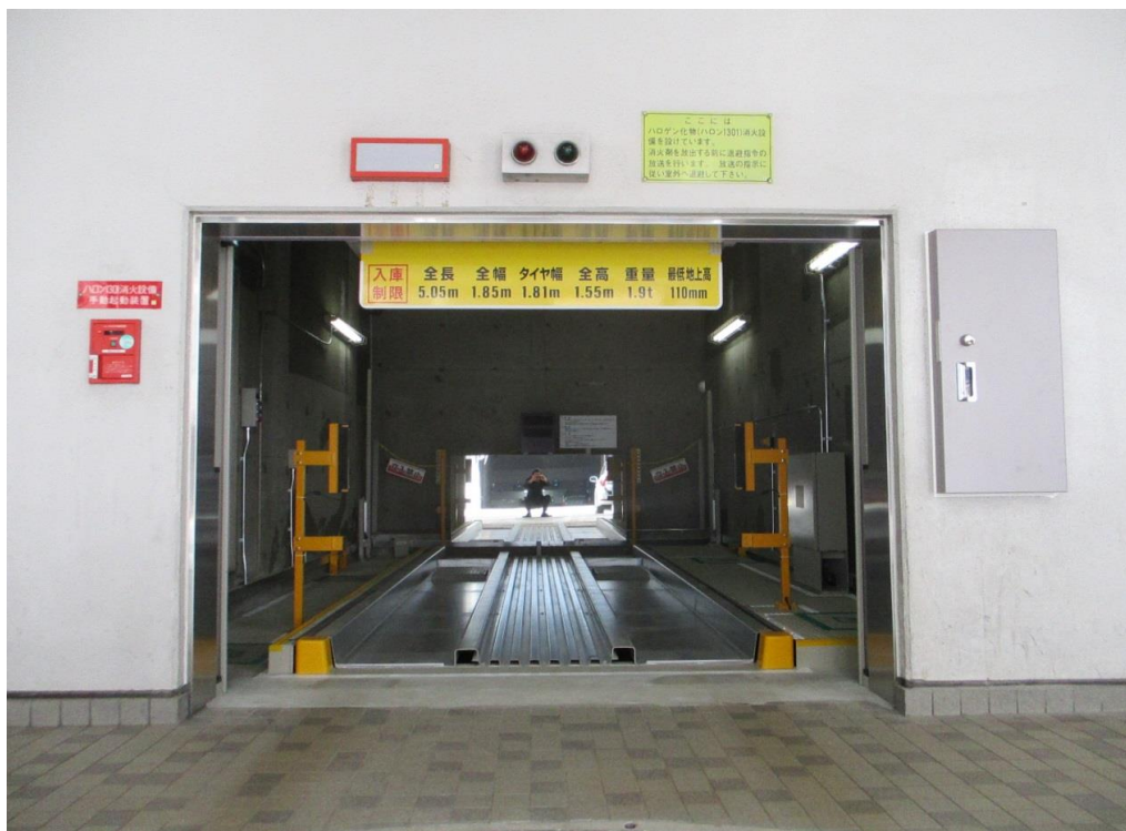
2.リプレース工事後
