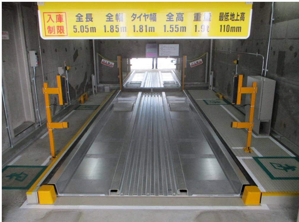
2.リプレース工事後(半ドア事故フェンスはセンサー式を採用したことで廃止・トレー腐食予防のため高耐食メッキ鋼板を採用)
