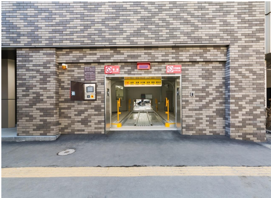
2.リプレース工事後
