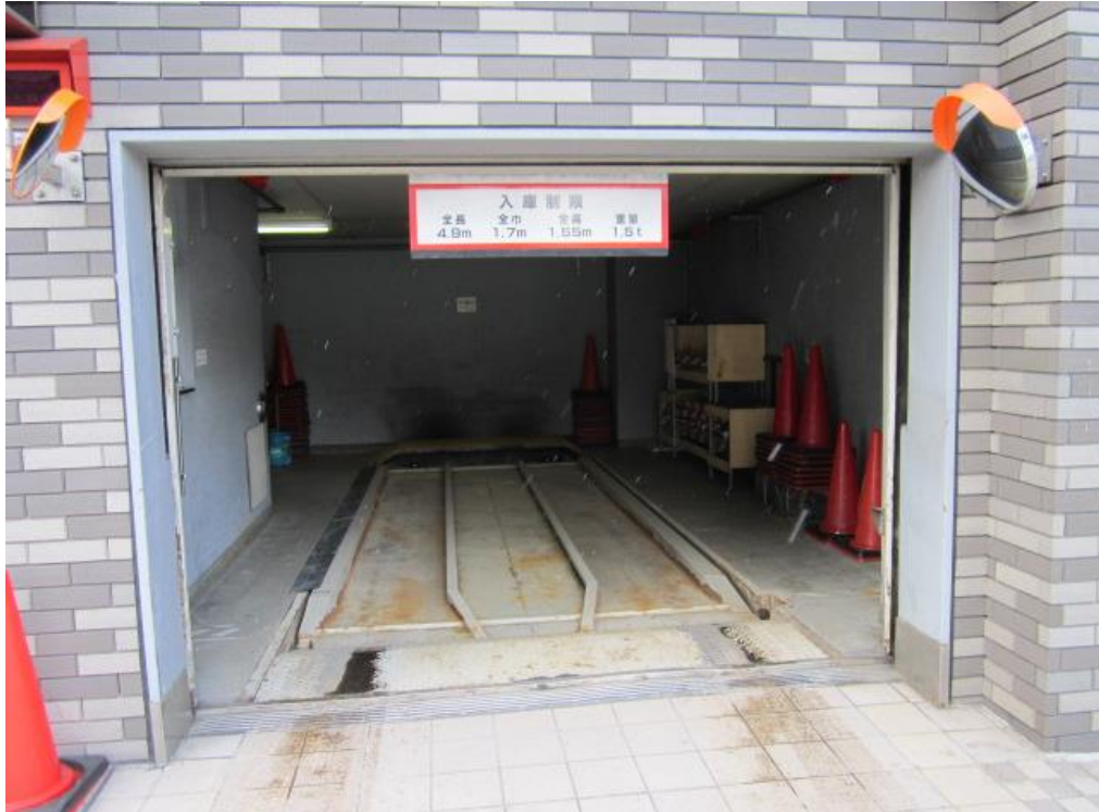
1.リプレース工事前(写真左操作盤室壁・雪害によりトレーが腐食)
