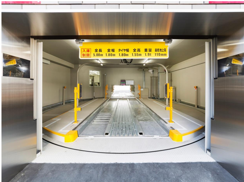
2.リプレース工事後(ターンテーブル内蔵型・トレー腐食予防のため高耐食メッキ鋼板を採用)
