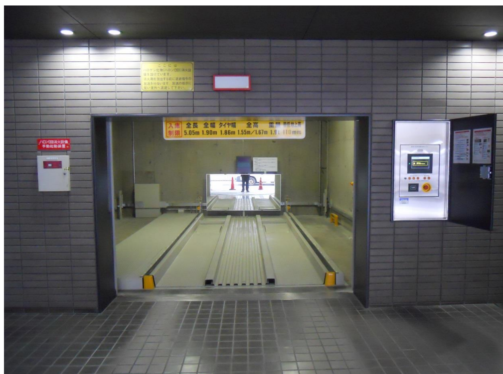
2.リプレース工事後
