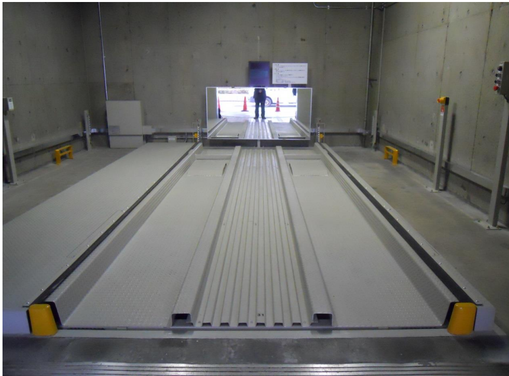
2.リプレース工事後(半ドア事故フェンスはセンサー式を採用したことで廃止)
