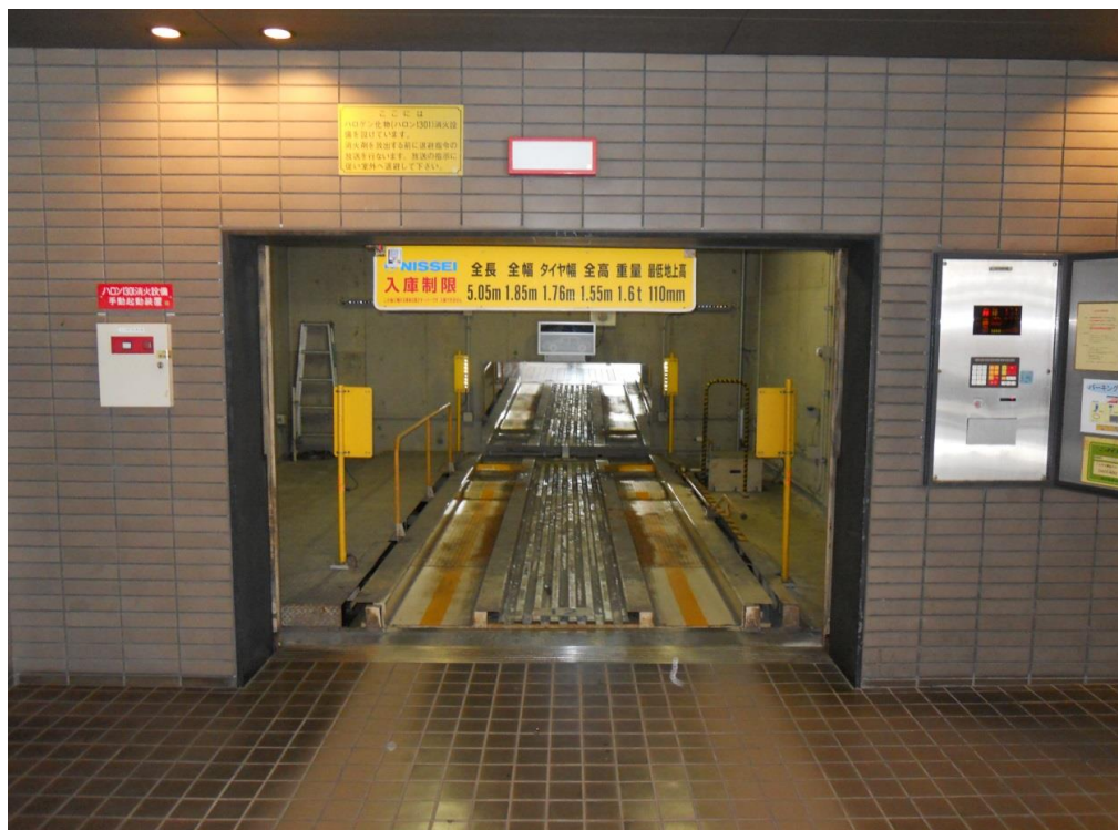
1.リプレース工事前
