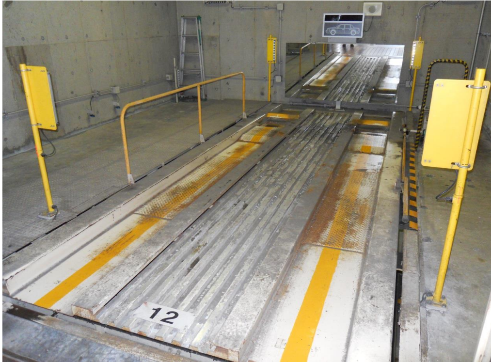
1.リプレース工事前(半ドア事故防止右側のみ可動フェンス付)
