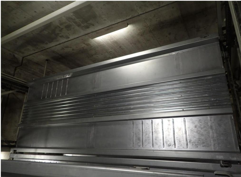
2.リプレース工事後(トレー腐食予防のため高耐食メッキ鋼板を採用)
