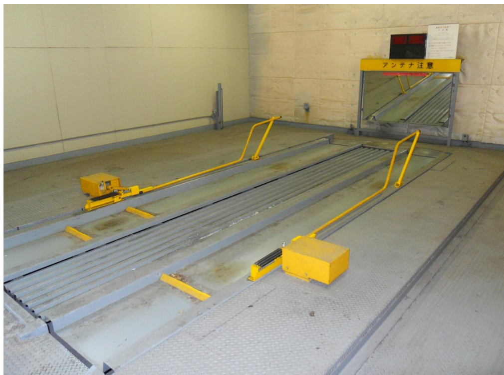
1.リプレイス工事前(半ドア事故防止フェンス付)
