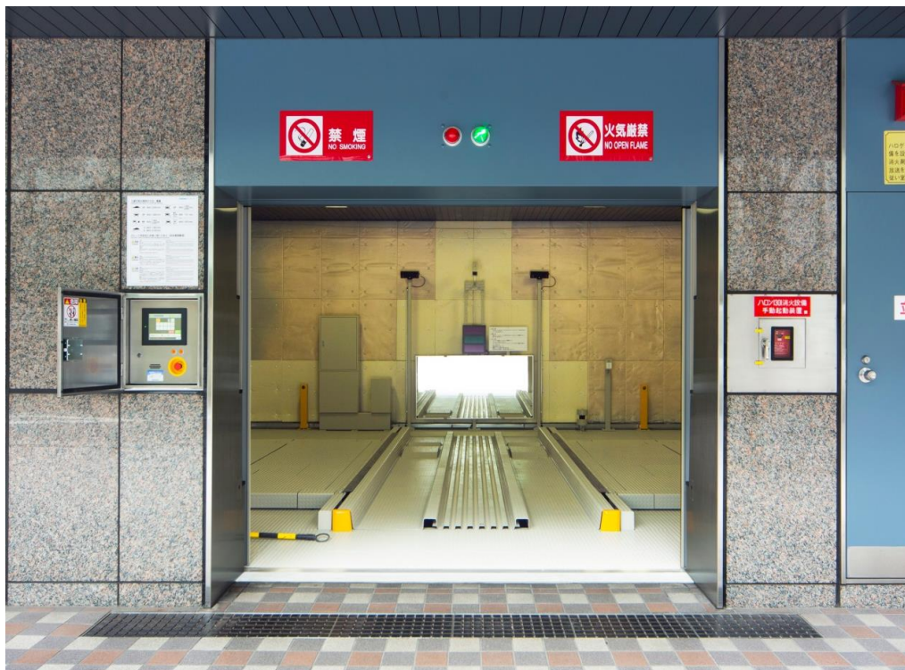
2.リプレース工事後
