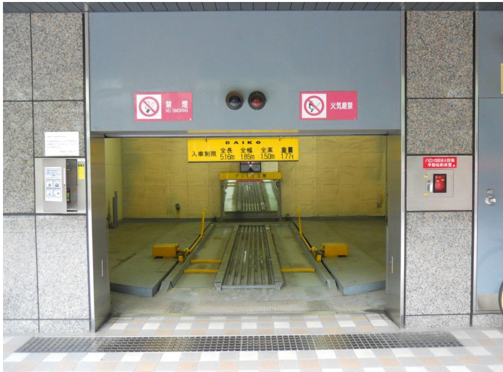
1.リプレース工事前
