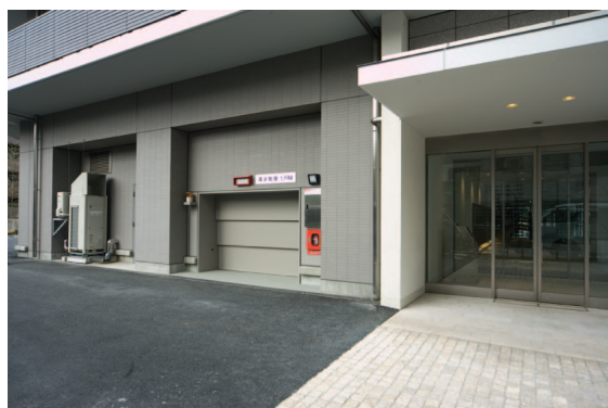
玄関口横のLEVELパーク入出庫口
