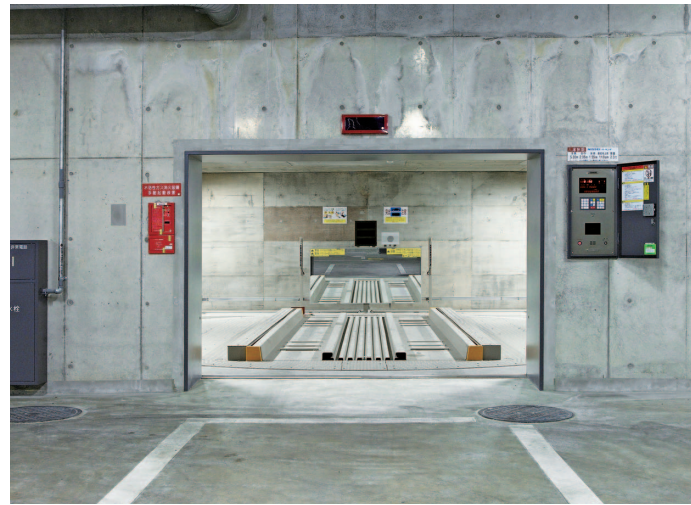
ターンテーブル内蔵の入出庫口スペース
