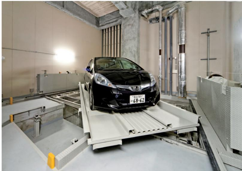
可動デッキが開き、トレーが90度旋回して車を格納
