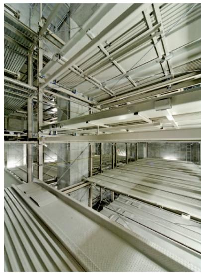
日精だけが実現できる水平循環の5層構造の設計
