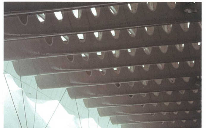
日本建築学会賞作品賞を受賞した「ビッグレットふくしま」の炭素繊維強化樹脂製大型キャノピー。
