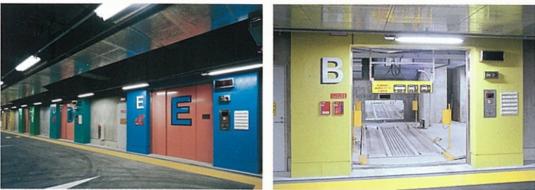
駐車場：ニッセイ・AUROパーク×5基 型式：AURO・CHSHT-35×3基 AURO・CHSMHT-42×2基 収容台数：計189台（駐車場合計311台）
