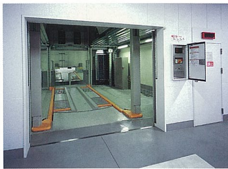
ELパーキングの入出庫口は、段差が少ないため車の乗降がしやすく、また、ターンテーブル内蔵で、前進入庫、前進出庫が可能です。
