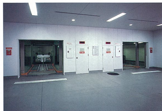
入出庫口の開口時の状況
