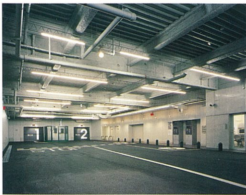
「街の広場に活用して貰いたい」と吊り照明や展示トランス設備のついた広い走行口
