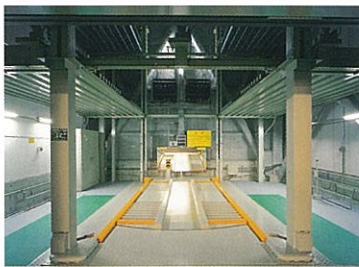
ELパーキングの入出庫口は段差が少ないため、車の乗降がしやすい
