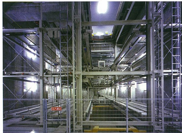
1号機の駐車室内部。1号機は3段構造、2号機は3段+一部2段構造の構成で、合わせて87台の収容台数を確保している。
