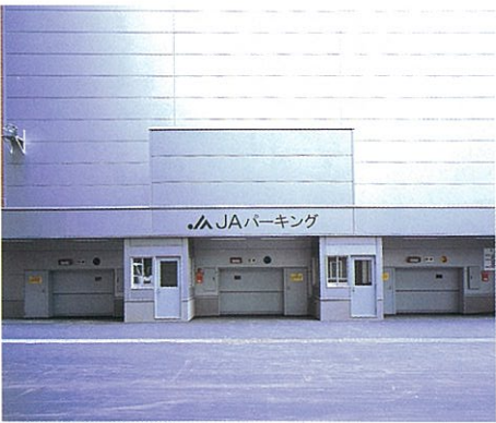
入出庫口の閉口時の状況
