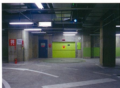
同様に直接乗込型のSPパークを採用した、普通乗用車に対応する2号機。出入庫口前方のターンテーブルを含め、コンパクトなレイアウトが可能のため、スロープのカーブ部分の外側に設置されている。
