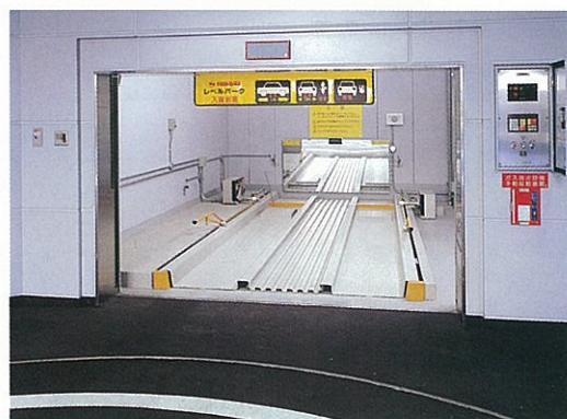
入出庫口の開口時の状況
