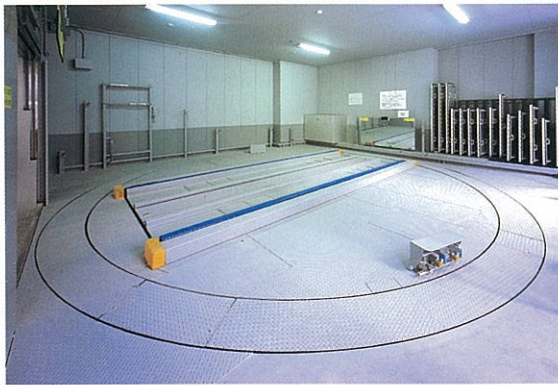
入出庫口内のターンテーブル
