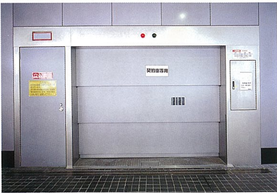
入出庫口の状況
