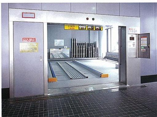
入出庫口の開口時の状況
