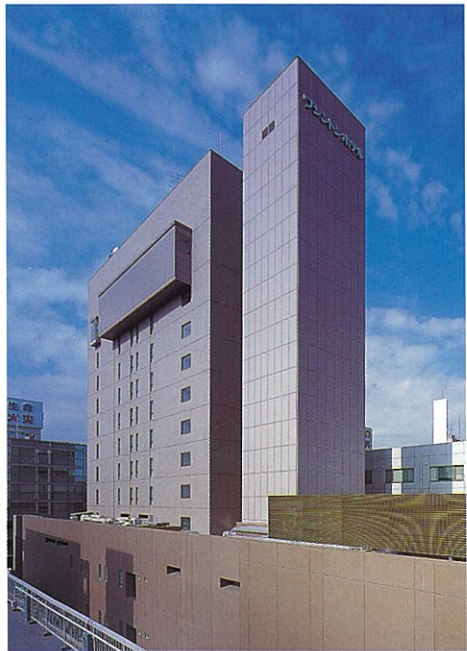
浦和駅からのアプローチ道路に面した、浦和ワシントンホテルの東側にあるエレベーター方式の独立鉄塔部分。スリムでムダのないタワー部分がホテルの外観ともマッチしている。（高54m）
