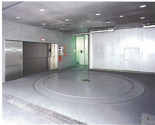
入出庫口の状況
