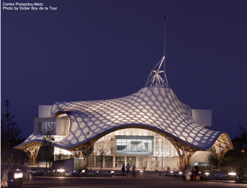
ボンビドー・センター メス(メス,フランス)
