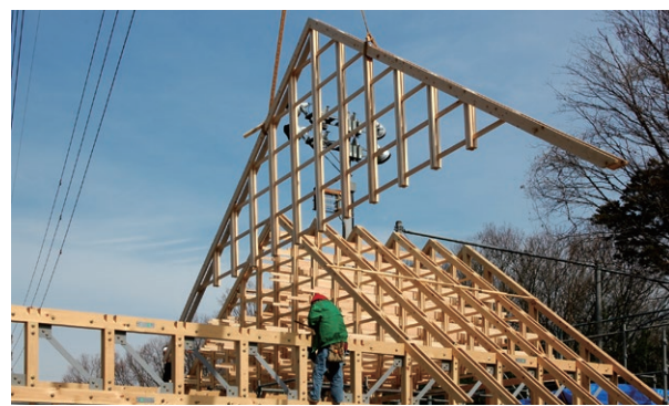
工学院大学弓道場施工現場 撮影：小川重雄
