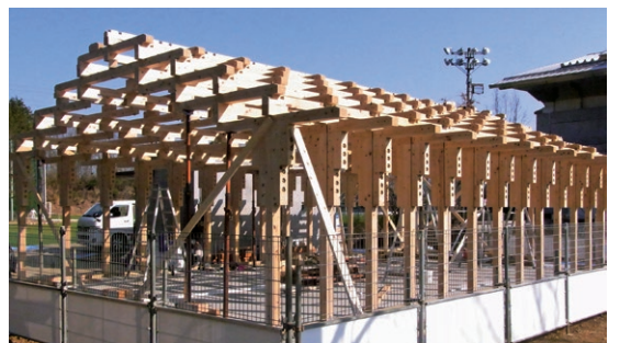
工学院大学ボクシング場施工現場 撮影:小川重雄
