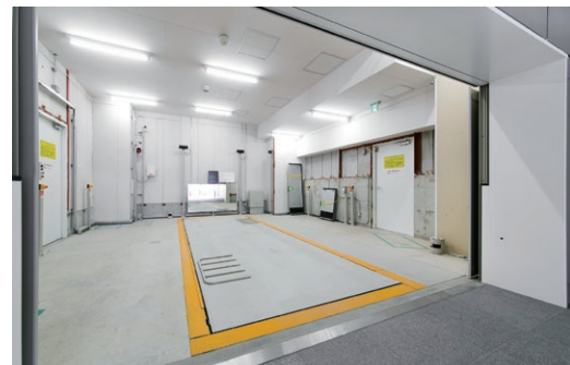
間口を広く取ることで、バリアフリーの通路幅を確保
