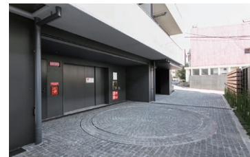
乗込み口スペース 石張りターンテーブルを設置
