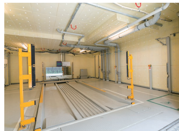
バリアフリーの通路幅を確保（写真:スロープトレイ）
