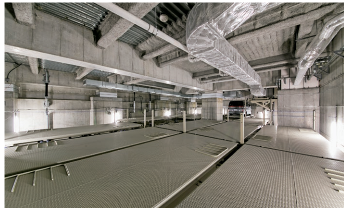
2層・28台駐車スペース(写真は上層)
