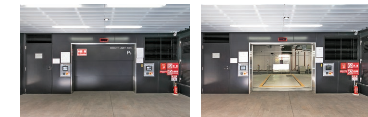
入庫口オートドア開閉時
