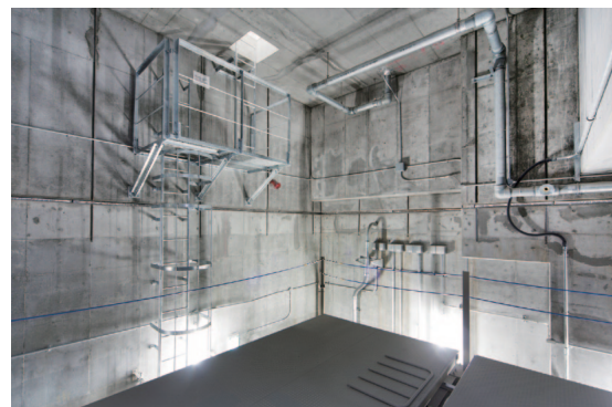
非常口も兼ねる点検口(建築側工事)
