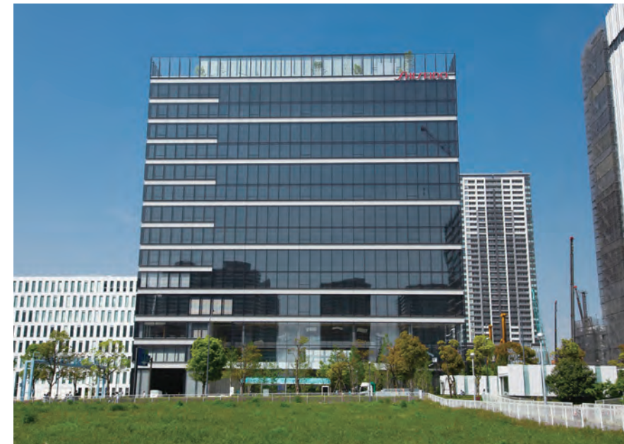
資生堂グローバルイノベーションセンター 外観
