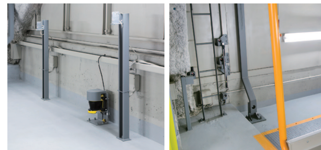
最新の安全装置を完備(左:パッシングセンサ、中央:車長車幅検知、右:人感センサ)
