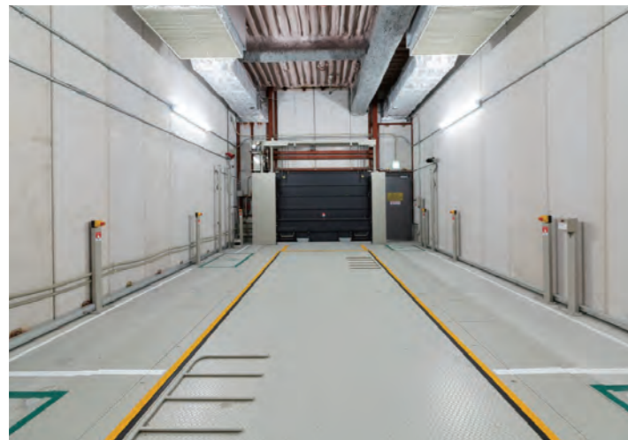
ターンテーブルを地下に設置することで、乗り込み口レイアウトがよりコンパクトに。
