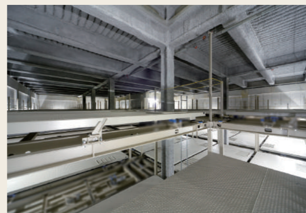
2層構造の駐車スペース
