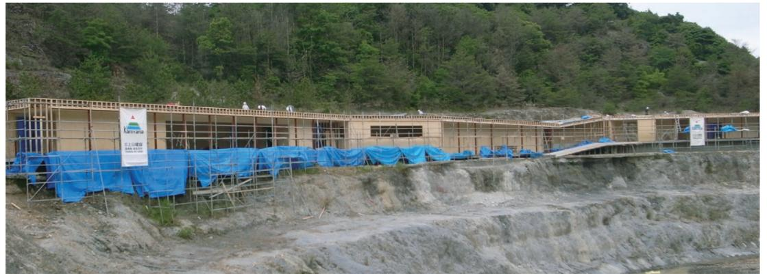
建設中、壁、屋根がCLTパネルで構成されている。YUKI HAYAMA STUDIO (武雄市)
