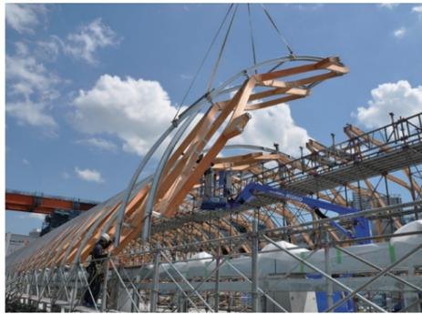
建設中、湾曲集材材を使用し、ユニット化された部材を短期間で組み立てた。
