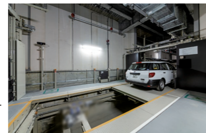
乗降室内：車両格納部(リフト)移動
