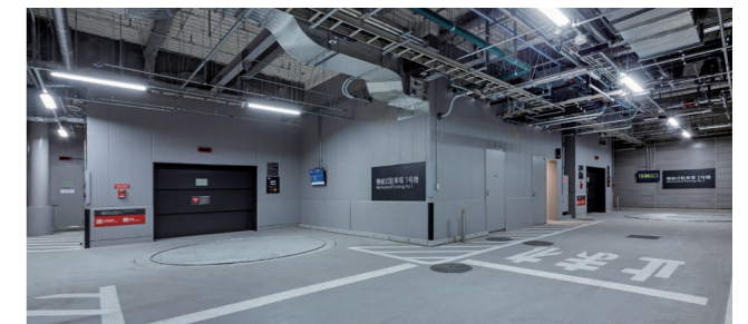
1号機・2号機：駐車場前面
