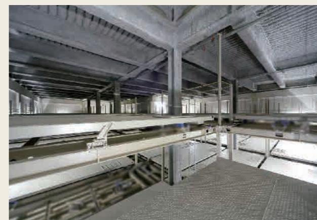
2層構造の駐車スペース
