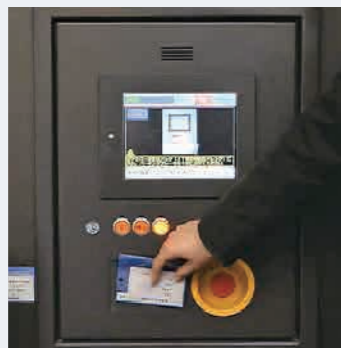
モニター表示 乗降室内にカメラを標準装備。操作盤の液晶で入出庫を確認できます。
