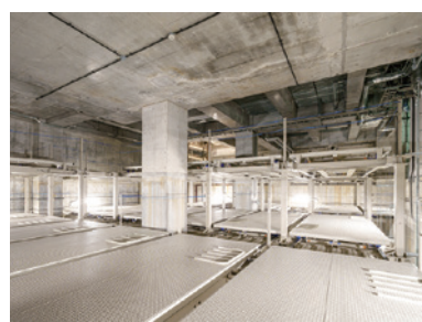
中間層奥側(上部カーエレベータピット)
