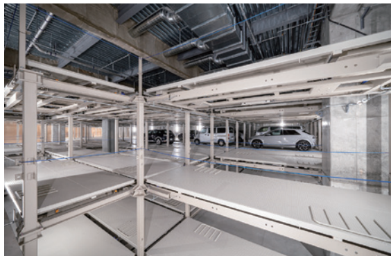
1号機 中間層側面
