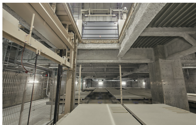
リフト部(上部開口)
