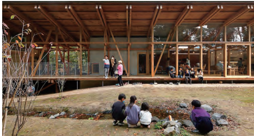
52間の縁側 Photo：黒住直臣
