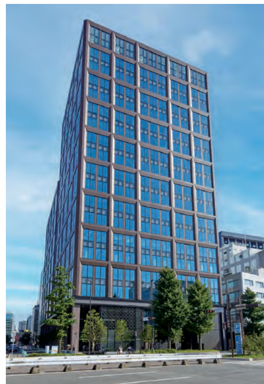
天神ブリッククロス北棟 外観
