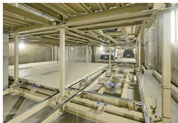
A号機格納部
